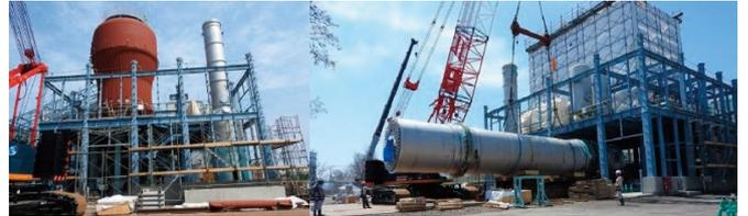
図12: PSD据付作業終了までの建物上部構造建方休止
