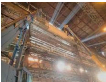
図16: 新設CRG上架
