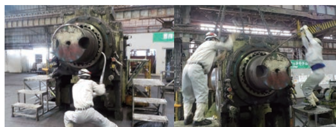
図2: ロックナット締付作業状況
