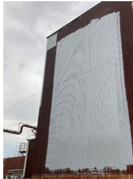
図 4：実証試験後の様子（壁塗装補修）
