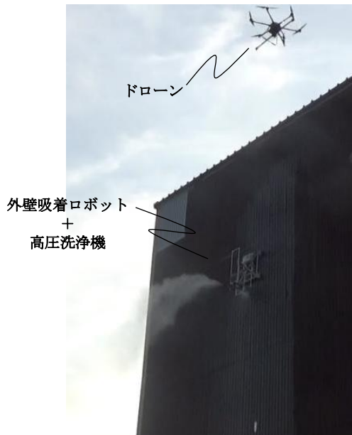
図 3：実証試験の様子（高圧洗浄状況）
