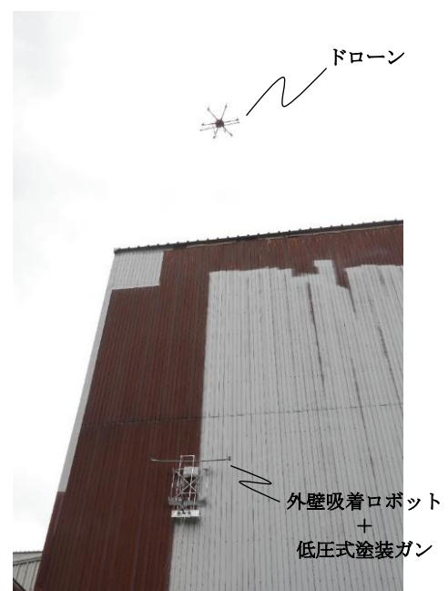
図2：実証試験中の様子（塗装状況）
