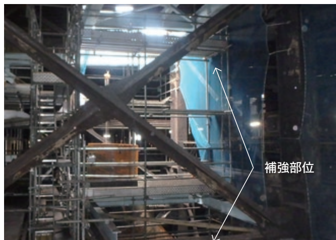
図7：建屋構造物の補強状況
