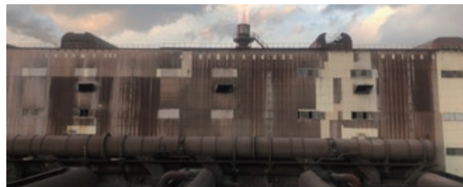
図15: 仮設工事完成
