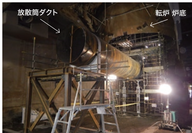
図5：#2転炉炉底切り欠き部へのダクト布設状況
