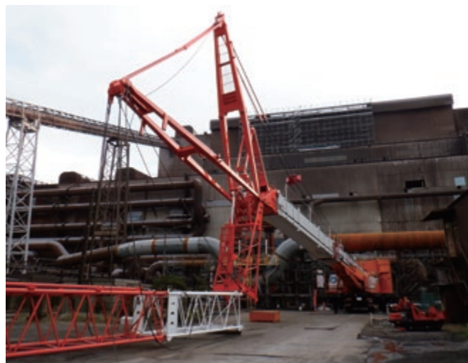
図6：550tの油圧移動式クレーン組立て状況
