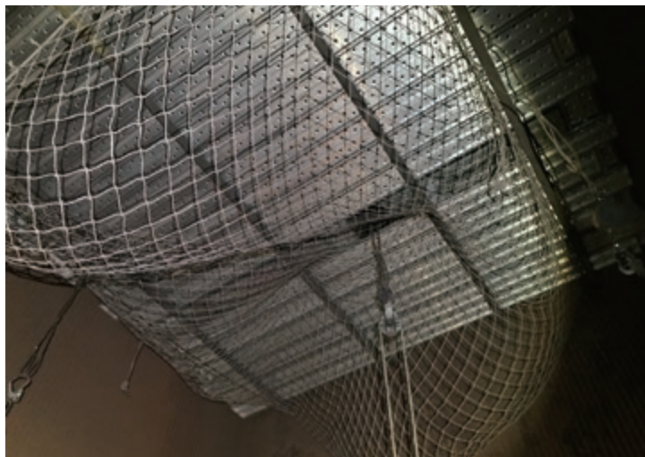
図19：実際の安全ネット設置写真
