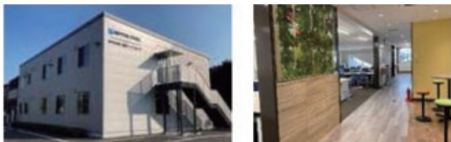
図22：大分建設センター（ZEB Ready）
