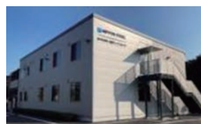
図6: 大分建設センター ZEB Ready
