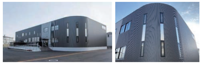
図12: 曲面外壁の外観
