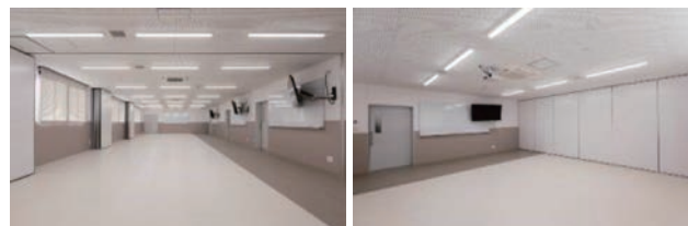
図17: スライディングウォールで間仕切り可能な教室
