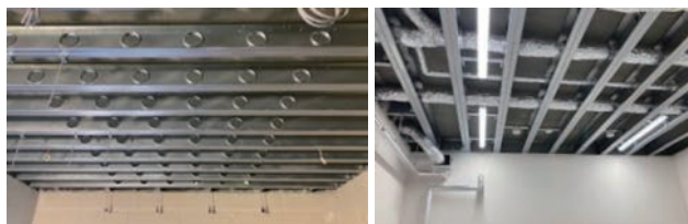
図20:穴あき根太とスケルトン天井
