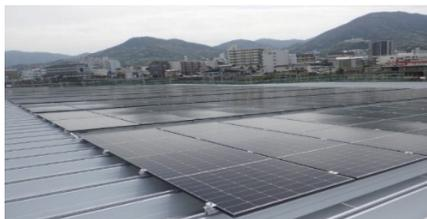
図10:自家発電型太陽光発電パネル設置状況
