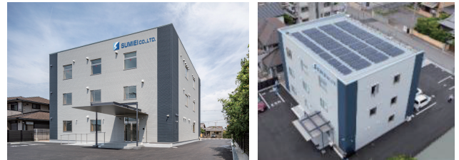
図9：S社新築事務所の完成写真(2023年7月)
