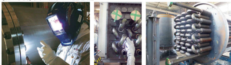
図11: 高度溶接技能例（狭隘箇所溶接）
