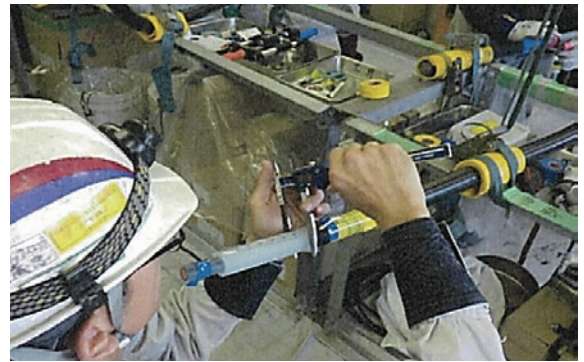
図7: 絶縁体仕上がり径測定 絶縁仕上り後の外径測定・記録 ・測定確度、測定位置を変えながら測定し規定値と比較し検査を実施
