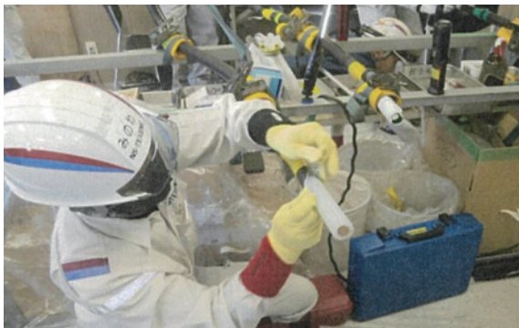
図5: 外部半導電層削り取り、ガラス仕上げ ・外導端部揃えと絶縁体ガラス掛けの仕上げ
