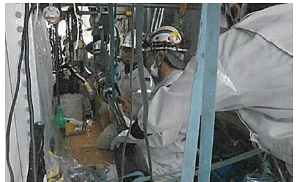
図8: RBJ 部品挿入 ・挿入の前・中・後の各検査確認
