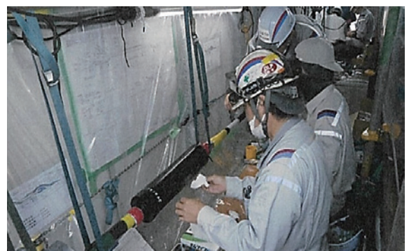
図10: RBJゴムユニット挿入・位置確認 ・挿入前点検(異物・ユニットの異常有無他etc) ・挿入位置確認
