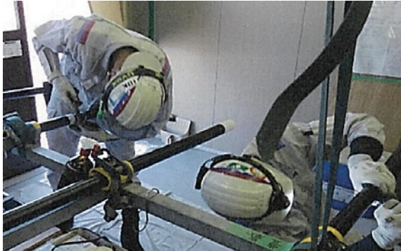
図4: 防食層剥ぎ取り
