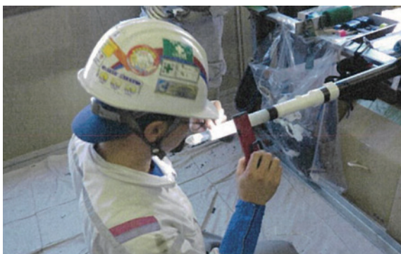
図6: 絶縁体表面確認 ・絶縁体表面仕上げ後の状態確認検査
