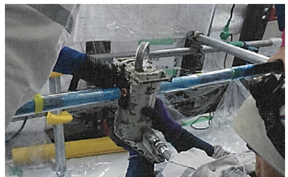
図9: RBJ導体接続管圧縮 ・圧縮・ダイス確認、ケーブル直線度確認、圧縮圧確認
