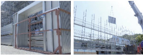
図3:パネル荷姿・パネル建方状況
