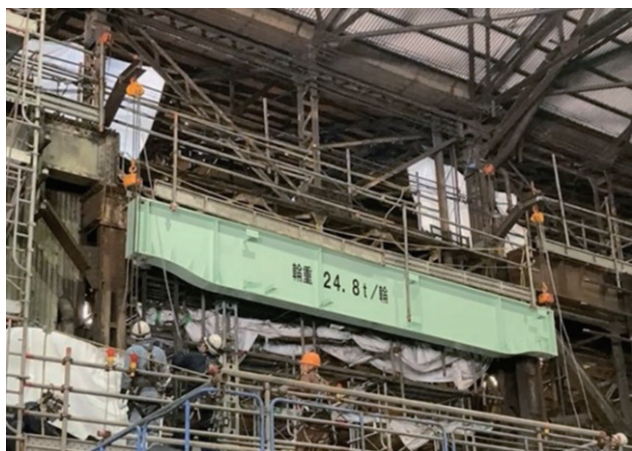
図8: アームによるCRG吊上げ状況
