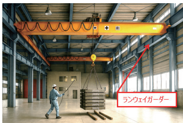
図1: 天井クレーンランウェイガーダー
