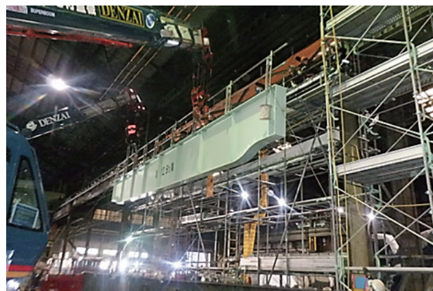
図2: 従来工法（レッカー使用）によるCRG更新
