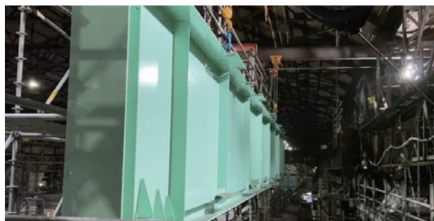
図13: ホイスト使用によるCRG吊上げ状況
