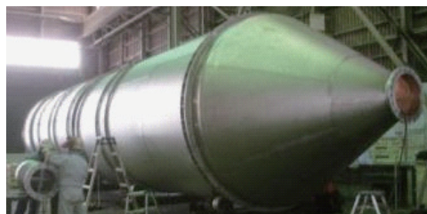
純チタンタンクの溶接 【3mφ×17mH】
