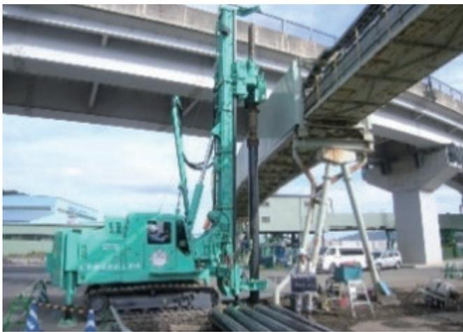
図8：沈下抑制対策状況 (NSエコパイル®)
