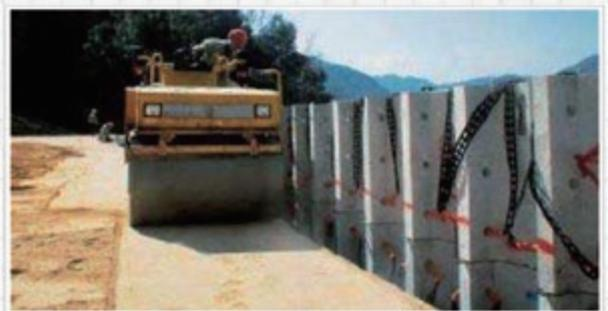
重機による壁面近傍転圧状況
