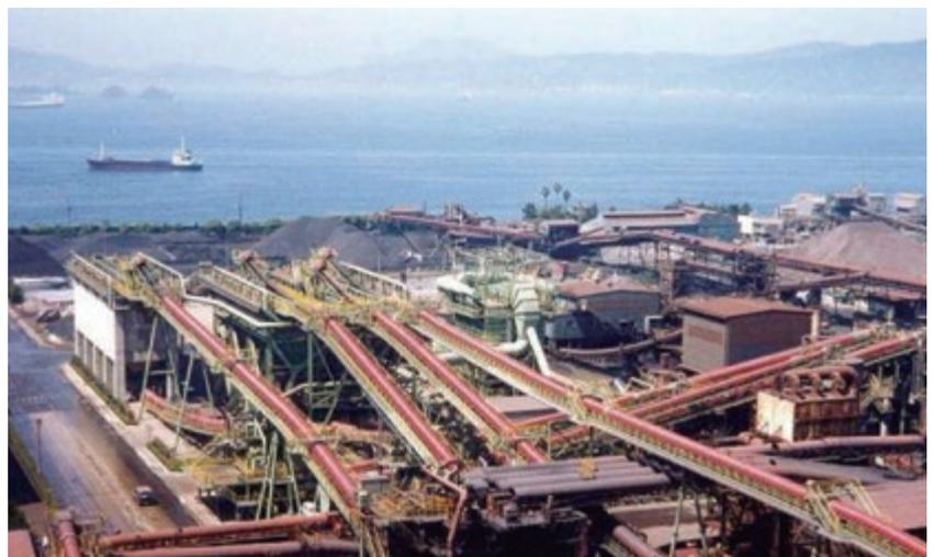
図1：高炉原料の受入・貯蔵・払出設備
